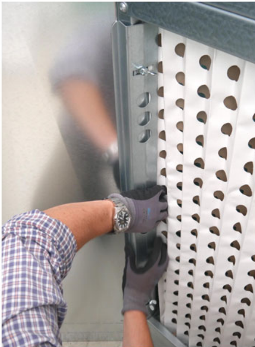
Bild links: Lösen bzw. Befestigen der seitlichen Halteklammern der Kartonfiltermatte
